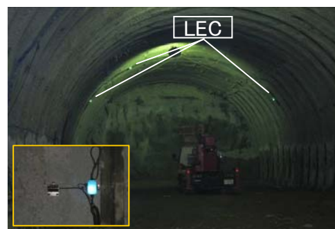
内空変位計とLEC設置状況
